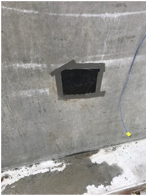
Foto 6: For at sikre udstøbningen mod hurtig udtørring, afdækkes området med tætsiddende plastik
