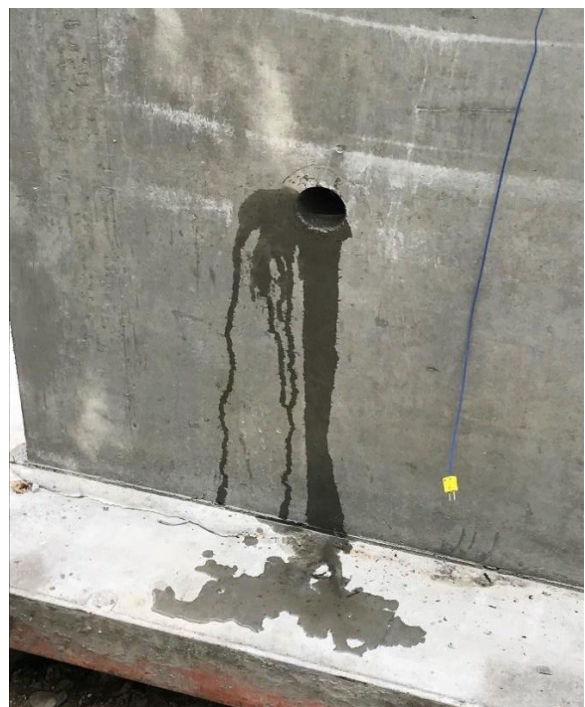
Foto 2: Klamshullet skylles med almindeligt vand, idet det sikres, at alt betonstøv er bortskyllet og betonen ikke er stærkt vandsugende
